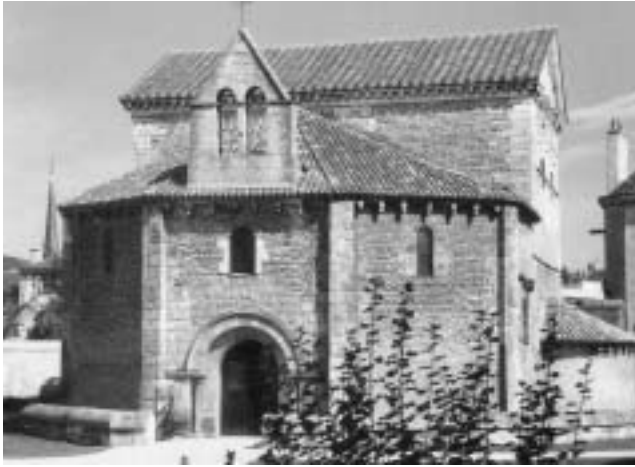
Baptistère St Jean (Poitiers) Édifié au milieu du IV e Siècle le plus ancien témoignage de l'architecture chrétienne en France
